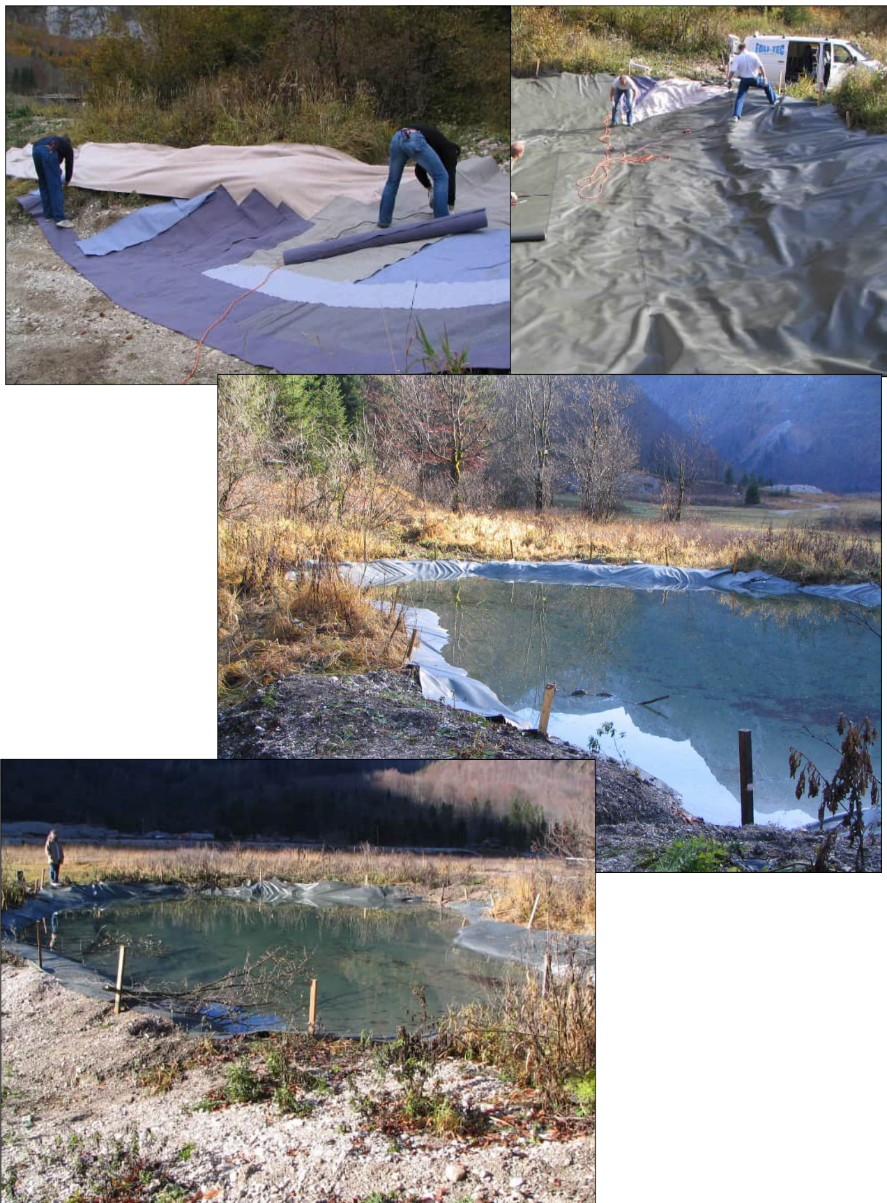
Abbildung 5-8: TÜPI Ramsau, Oktober/November 2006: Fertigstellung des Folienteiches. Foto W. Weißmair.
